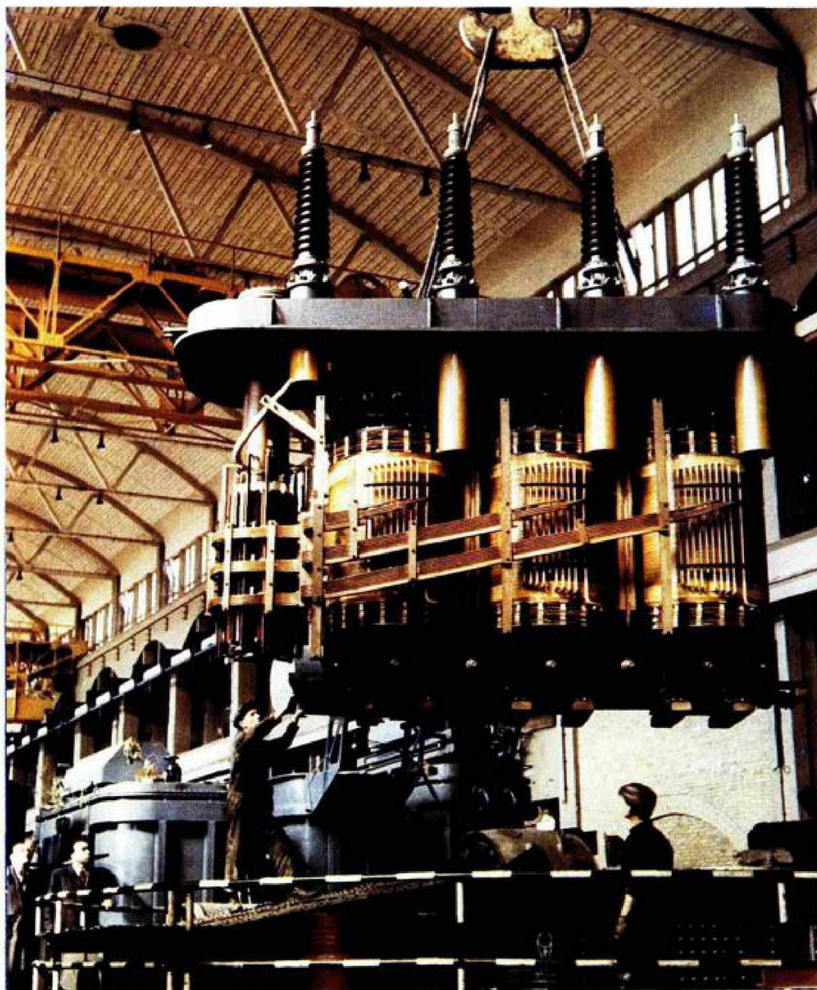
Detalji iz proizvodnje transformatora u tvornici Rade Končar u Zagrebu 1954. godine presnimka fotografije (Muzej grada Zagreba)
