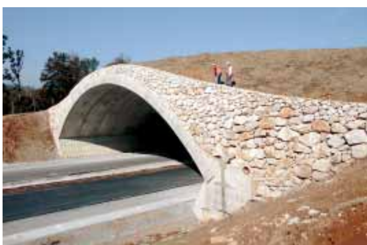
ZELENI MOST DEDIN: Radnici na mostu netom nakon završetka njegove gradnje
