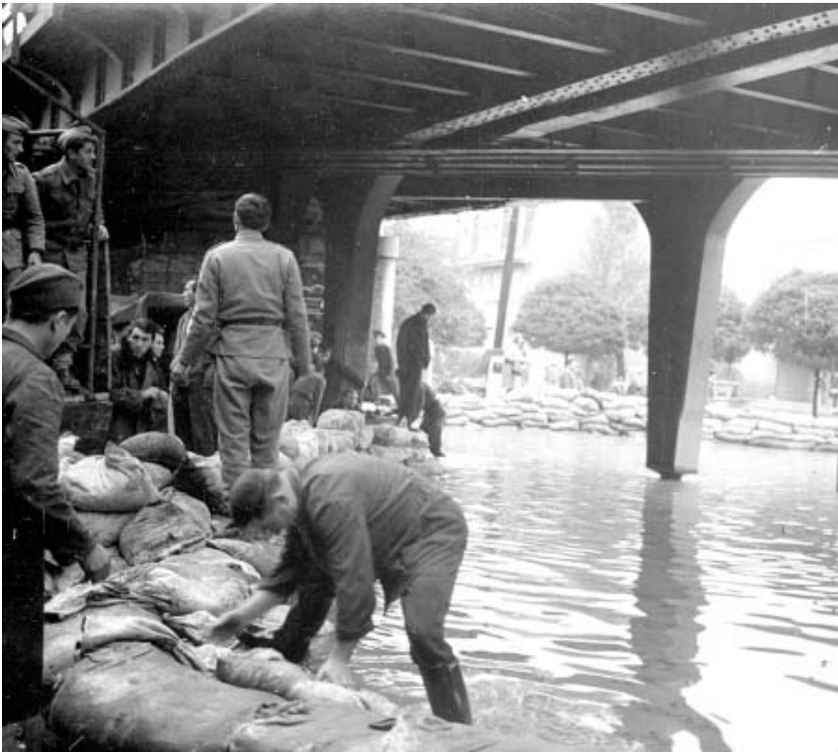
Voda je zaustavljena zečijm nasipima pod nadvožnjakom kod današnjega Cibonina tornja na Savskoj cesti
