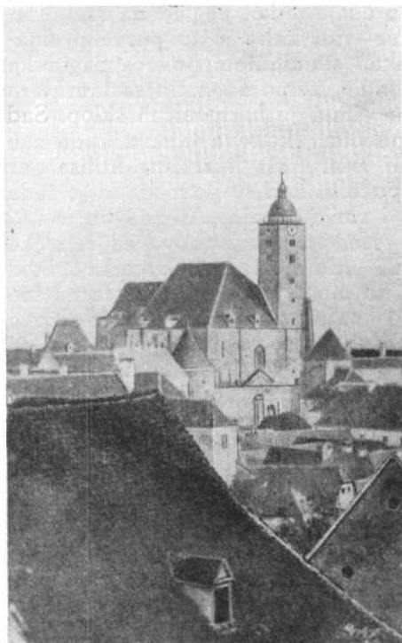
Stara zagrebačka katedrala u g. 1861. U jakim se formama prilagodila svojoj okolini, renesansni toranj izvrsno pristaje uz gotičku građevinu. Graditelj Albertal nije ni htio graditi lijevi toranj; znao je kako je tu nestalno tlo, ali je znao i to, da jedan dobar toranj vrijedi više nego dva loša!
