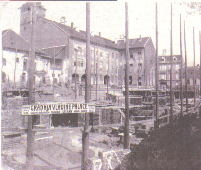
Gradnja Vladine palače, 21. 7. 1908.
