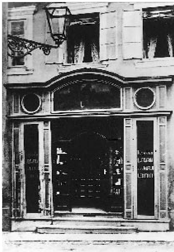
Slika 3. Opatovina 7 - portal ljekarne nakon obnove 1883. Foto-teka MGZ, Inv. br. 1899-IV-84.
